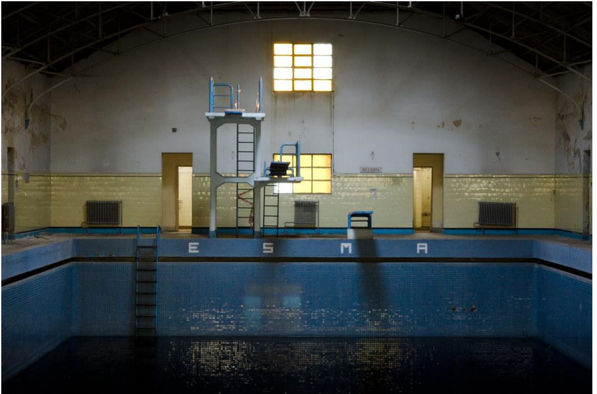
Pileta de natación
