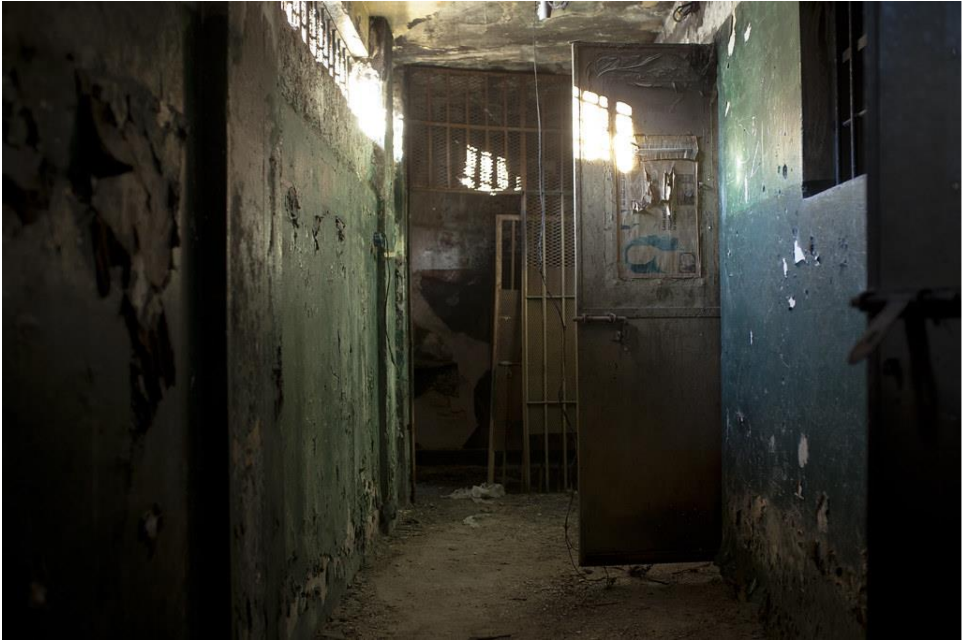
Pasillo de ingreso a las celdas
