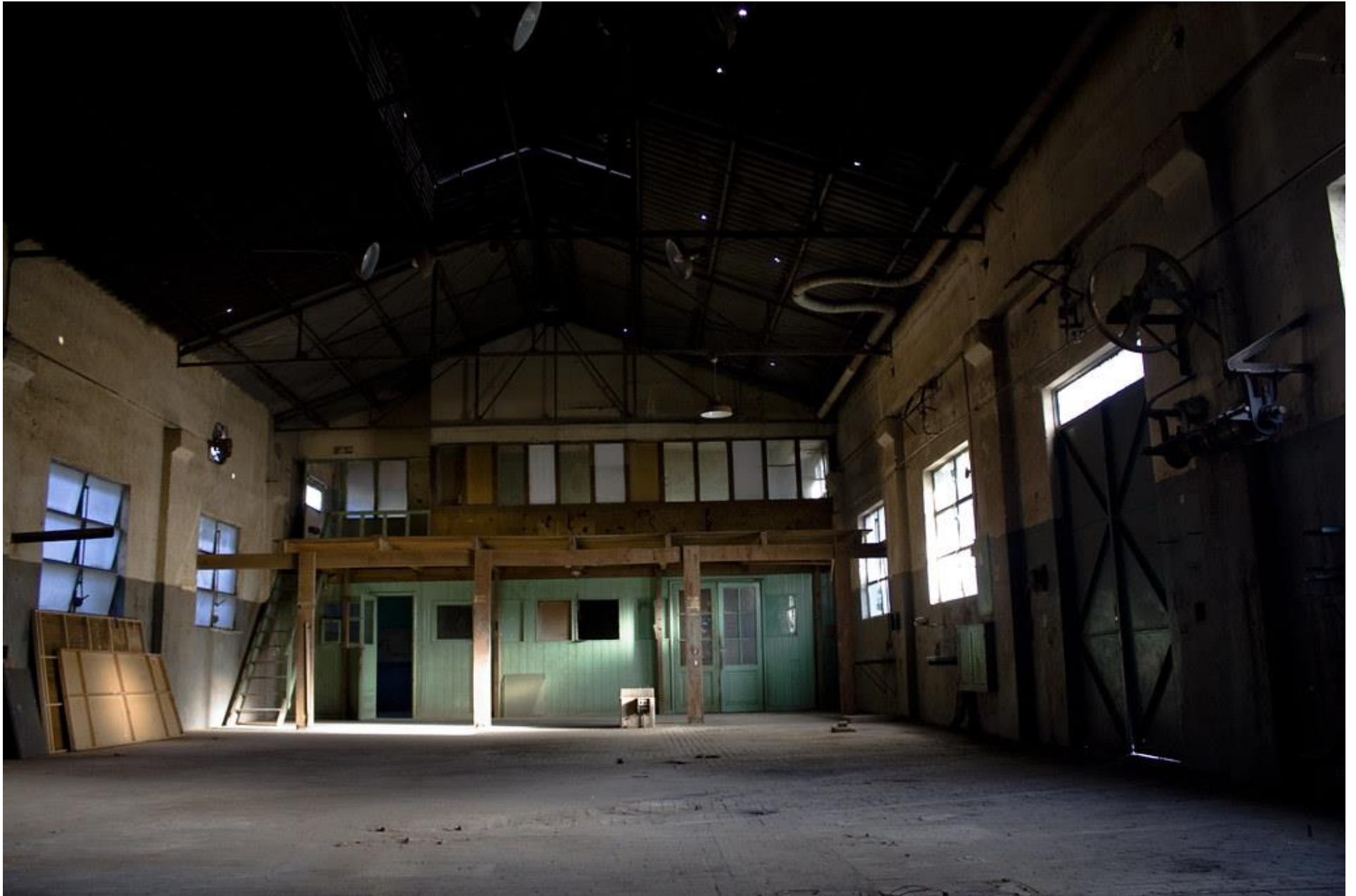
Pabellón de Máquinas
